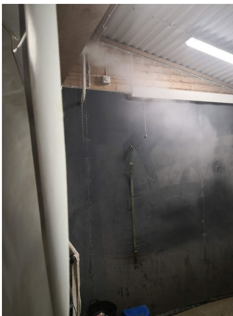
Dimning av duschrummet med 2 % Hippofix.
