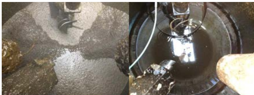
Figur 6. Bild från pumpbrunnen som användes för att konvertera hästgödseln till en pumbar slurry före och efter att bottensediment avlägsnats.
